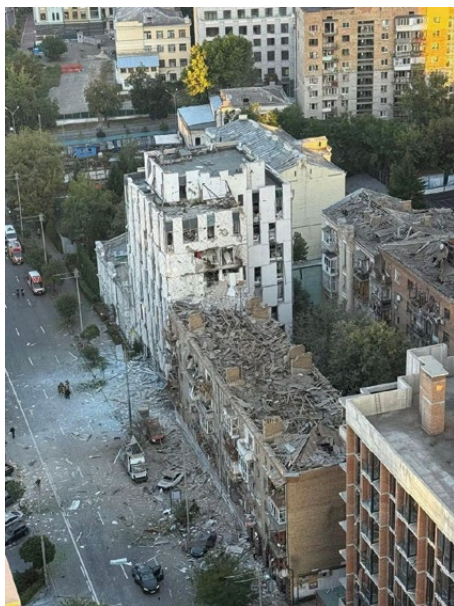
■ Фото пошкодженої будівлі, де знаходився офіс організації
